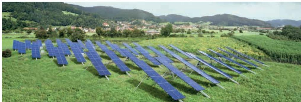
Stabilimento di Rheinau. I 28 SunCarrier 22, impianti ad inseguimento dell'irraggiamento solare, compatti e facili da installare, producono complessivamente 135.000 kWh di elettricità l'anno.
